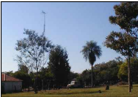
Una de sus localizaciones, con la antena de transmisión
