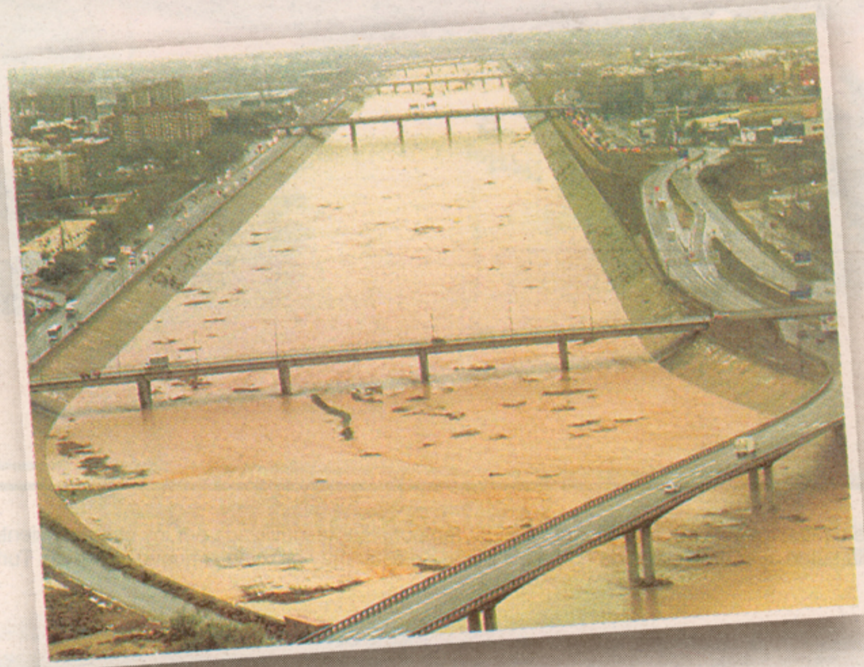
El nuevo cauce del Turia. El cauce presentaba una imagen inusual al llevar su lecho grandes cantidades de agua.
