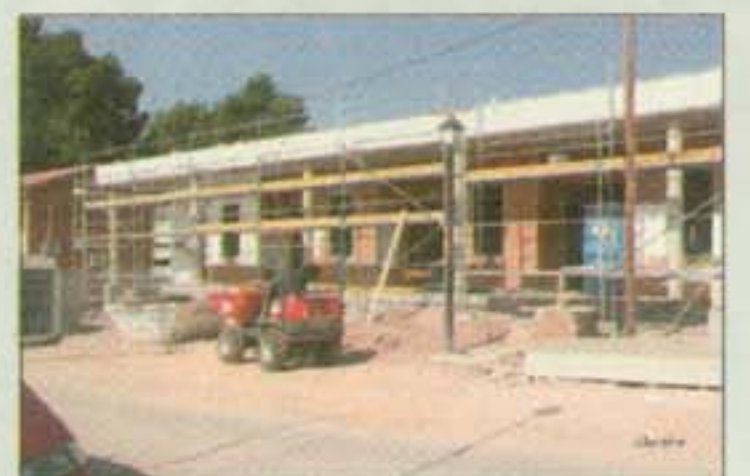
Obras de la futura Escuela Infantil.
